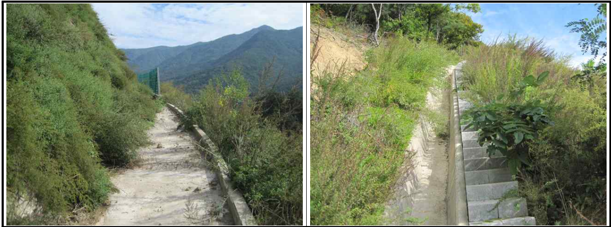
【그림 14.3.3】 배수시설 전경
